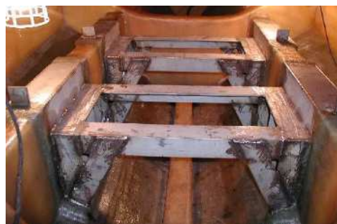
FRP 船に対し、鉄架台を設置した例
