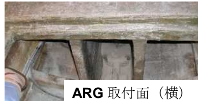
FRP リブを追加し、鉄板で補強した例
