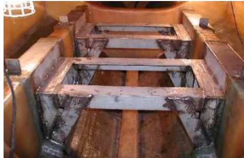
FRP 船に対し、鉄架台を設置した例
