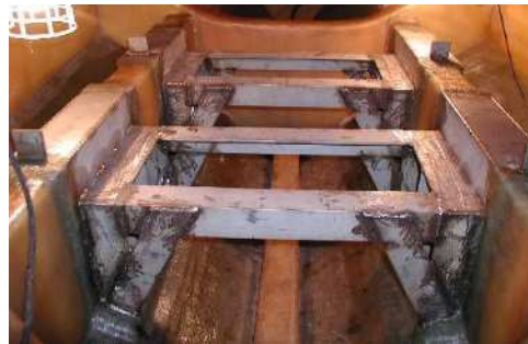
FRP 船に対し、鉄架台を設置した例
