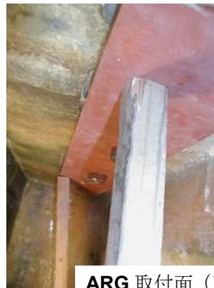
FRP リブを追加し、鉄板で補強した例
