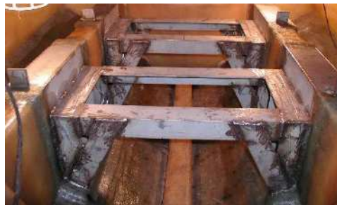
FRP 船に対し、鉄架台を設置した例
